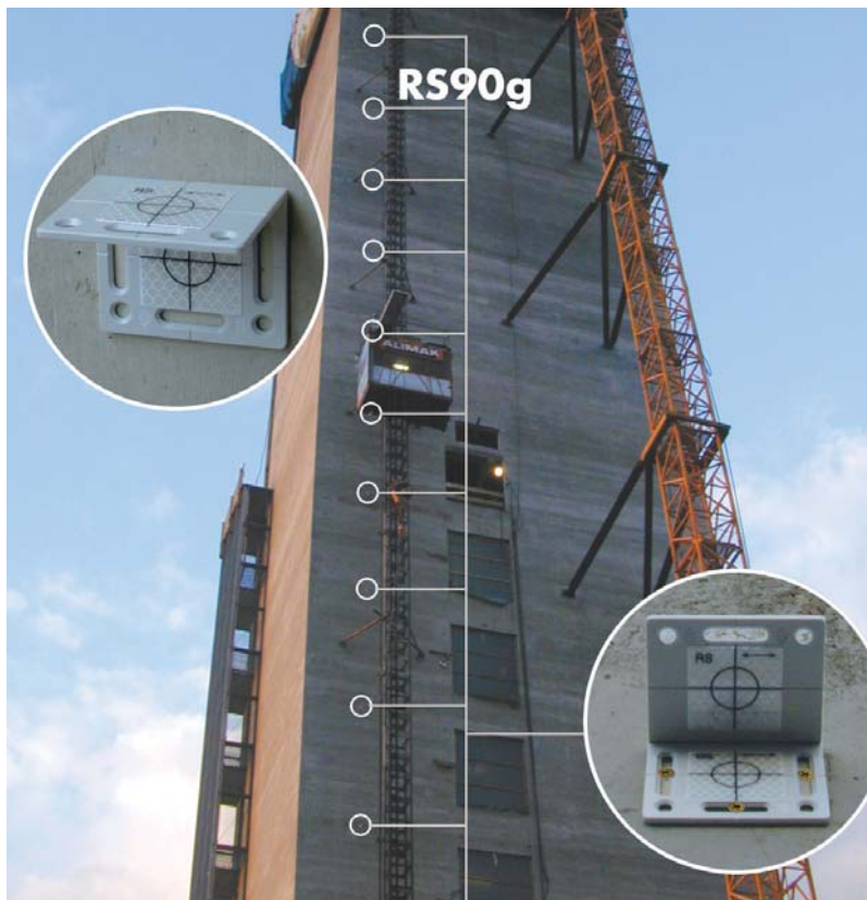
Posuvné bednění s Rs90g
