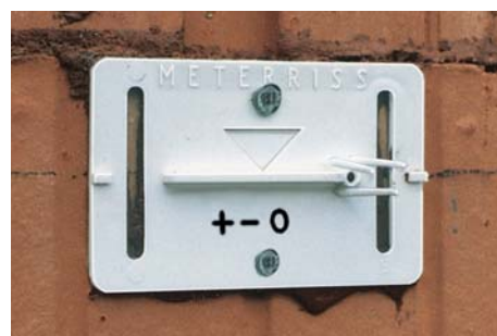
RS21w na cihlové stěně
